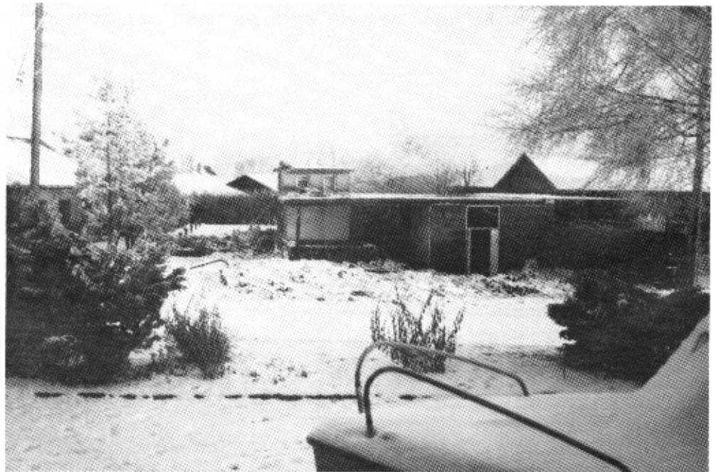
Kystparkens vandværk med det »dejlige« salte vand.
